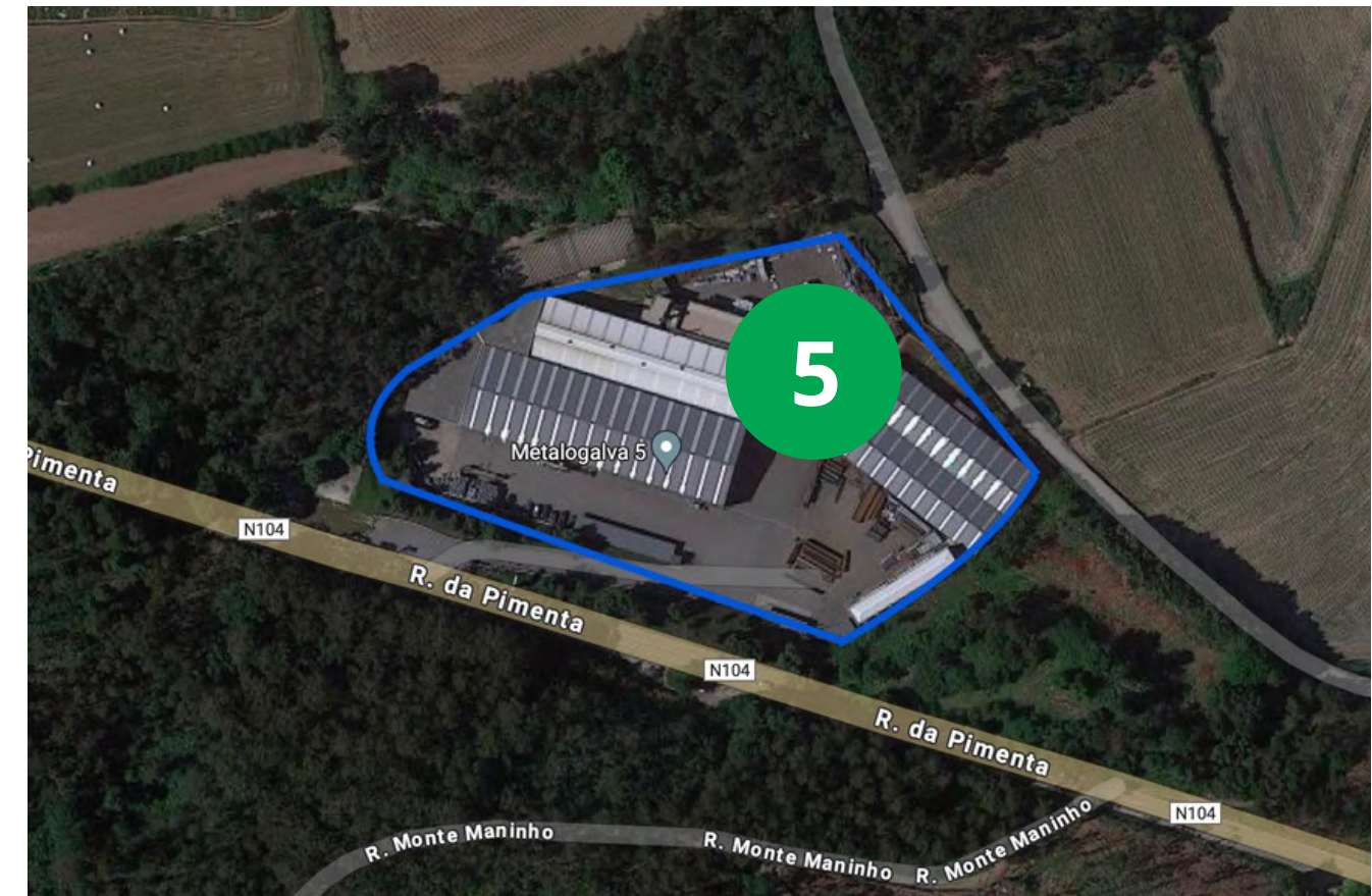
5 TROFA Perfilagem Fabrico de Estruturas Soldadas
